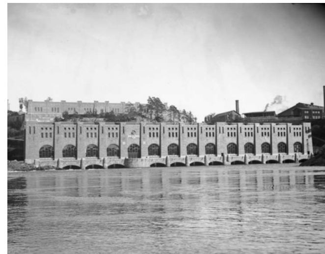
Olidans kraftstation i Trollhättan. Bygget påbörjades 1907, de första 4 aggregaten togs i drift mars 1910. Foto fr. eft. 1921, då kraftverket är utbyggt åt höger. Källa: Vänersborgs museum.
